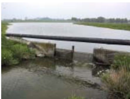
Vattennivån i våtmarken kan regleras med brädsättar i utloppsdatumet.
